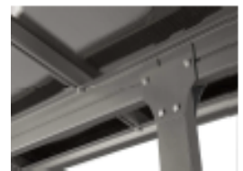
Piede sottotetto centrale
