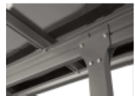
Piede sottotetto centrale
